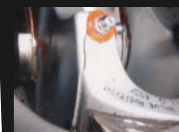
Fissures Le train d'atterrissage endommagé a heurté trop durement la piste.
